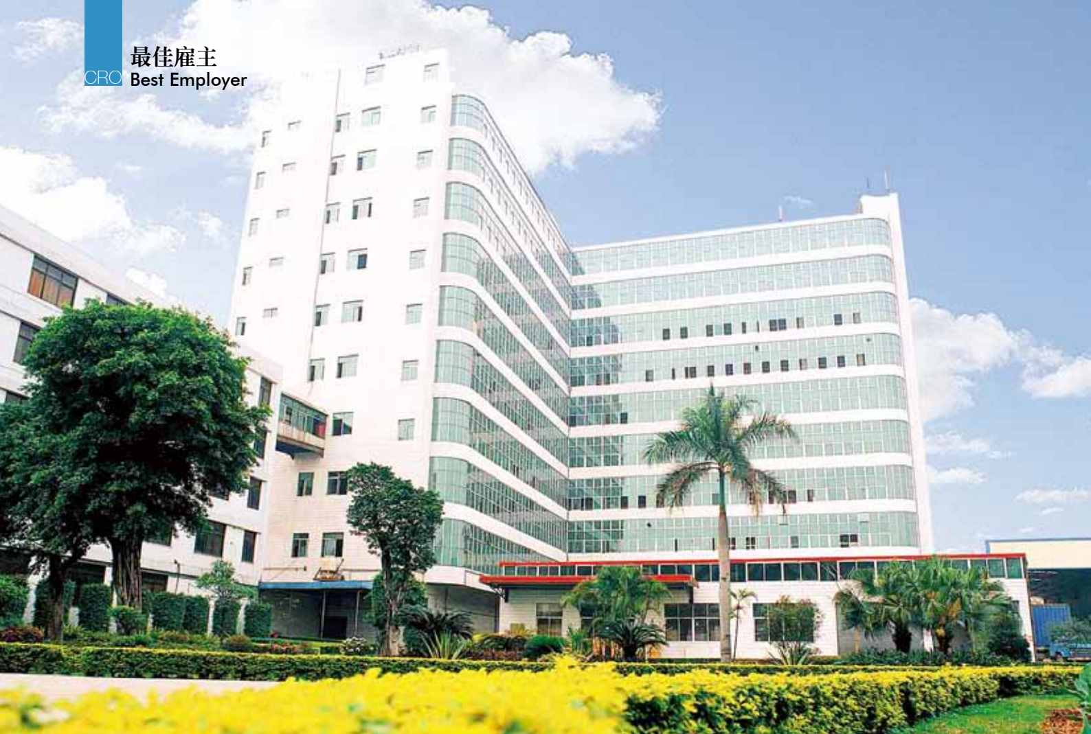
▲佛山电器照明股份有限公司办公楼外景图。
